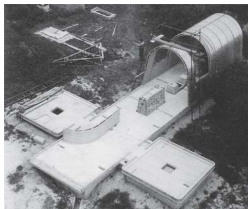
Fig. 55: Erecting the sandwich elements Jean Prouvé: La Méridienne de l'observatoire, Paris (F), 1951
