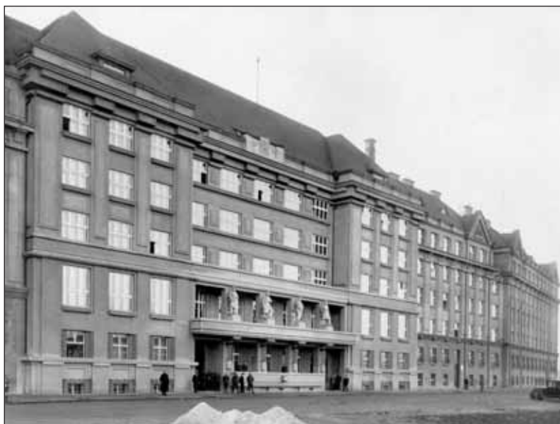
Pro potřeby Hlavního štábu čs. branné moci bylo v roce 1924 dokončeno sídlo situované v Praze-Bubenči. Označovalo se poněkud komplikovaně jako domy pro dočasné umístění úřadoven Ministerstva národní obrany. Mělo jít o provizorní řešení, ale složky ministerstva zde setrvaly až do roku 1939.
