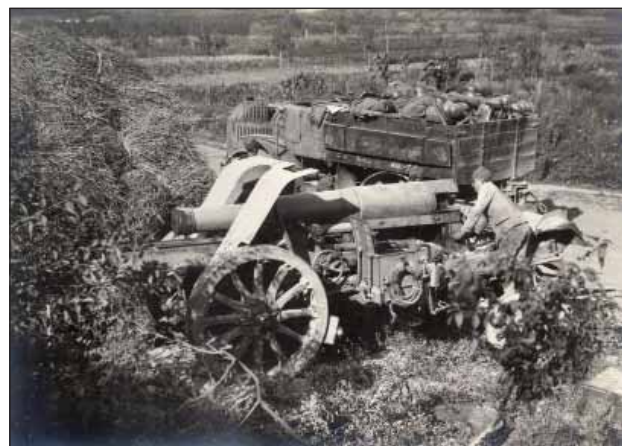
Robustní 15cm těžká houfnice vz. 15 v pochodové poloze při zaujímání palebného postavení. V pozadí tahač Daimler vz. 17.
