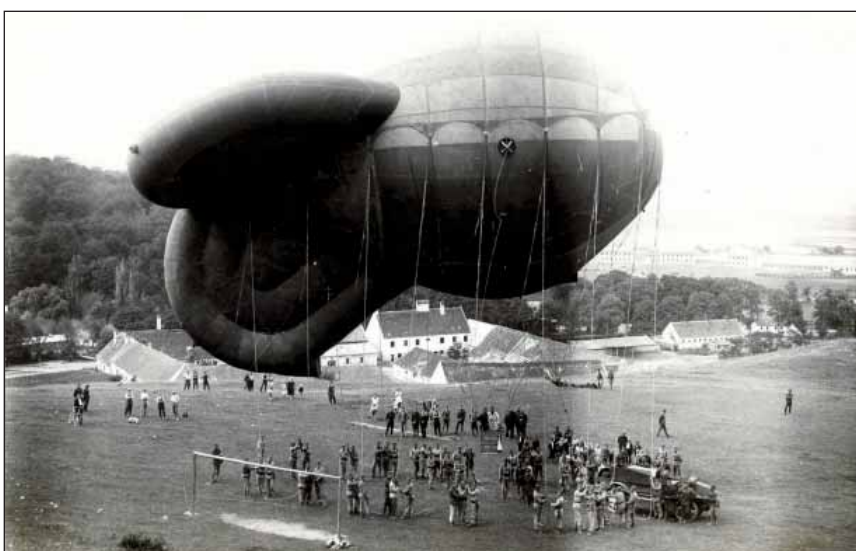
Upoutaný balón Brewetti z výzbroje balónové roty 1. Pod balónem je patrný navíjecí vůz Latil.
