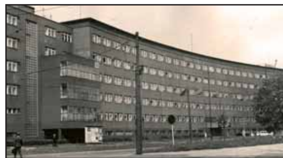
Budova Vojenské technické akademie v Brně zvaná „Rohlík“
