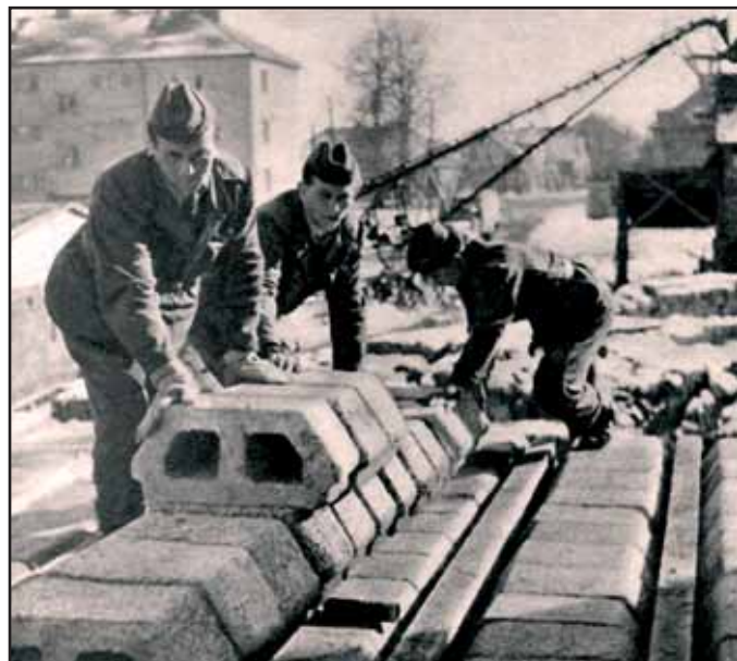
Vojenští stavbaři vojenského stavebního podniku Konstruktiva stavějí vojenské byty
