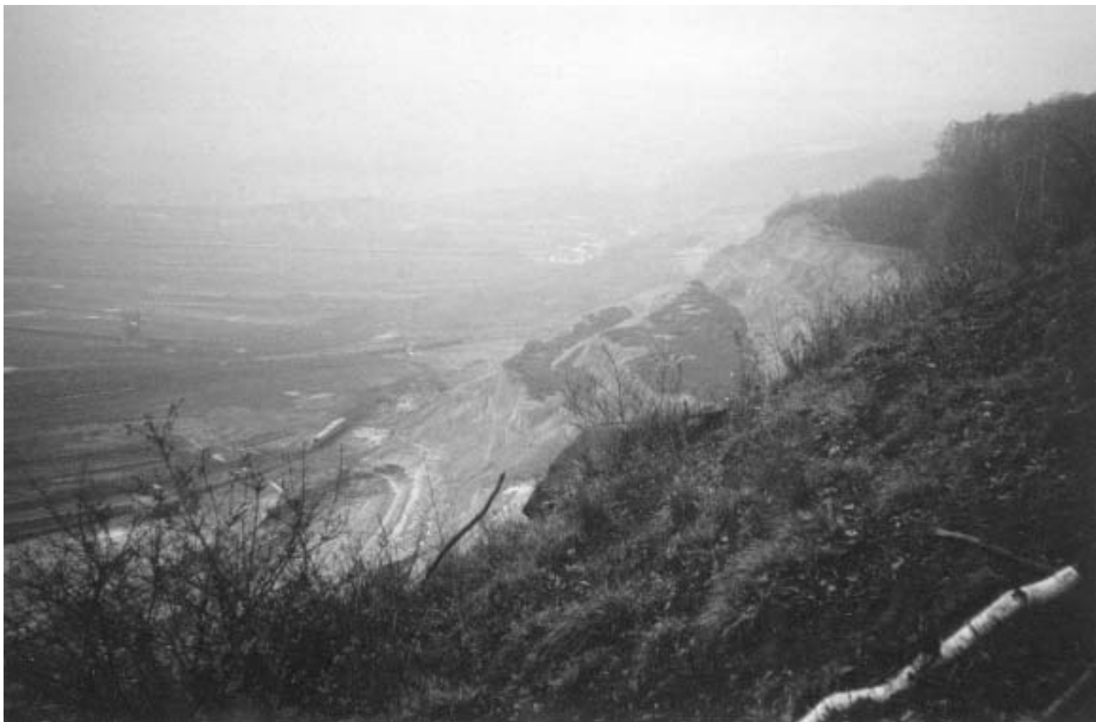
Zásahy lomu ČSA do svahu Krušných hor v prostoru Jánský vrch na západ od ochranného pilíře zámku Jezeří a Albrechtického arboreta. Odstranění lesa, půdního pokryvu a stupňovité odtěžení části svahu. Stejně následky pro nejcennější část svahu krušnohorského svahu by mělo porušení územních ekologických limitů, postup lomu ČSA do prostoru Černice - Horní Jiřetín a těžby po výchoz sloje.
