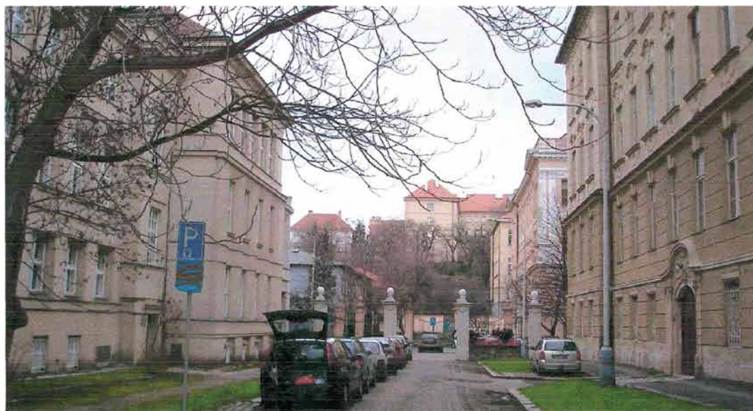
Obr. 15: Votočková ulice (kolmá na ul. Albertov) – pro historický soubor kampusu je charakteristická výšková hladina (zde 4 podlaží včetně podkrovi s členitou sedlovou střechou) a přímá uliční čára, kterou jednotlivé objekty důsledně sledují. Patrným principem je též dynamizace uličního prostoru rizalitou s ustoupením střední hmoty objektu do 2. plánu. V průhledech se tak významně uplatňují rizalitová nároží, které zjemňují i zlidšřují měřitko samotných staveb.
