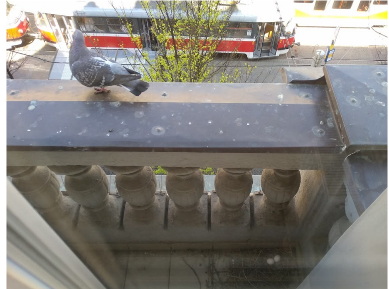
Holub hlídá hnízdo s vejci na balkóně Nejvyššího správního soudu
