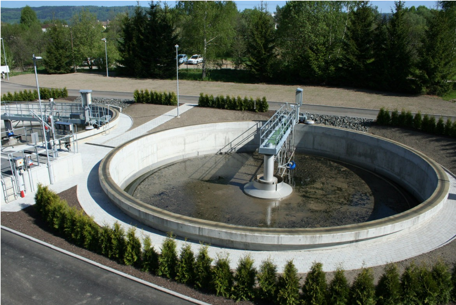
Výstavba čistírny odpadních vod za městem
