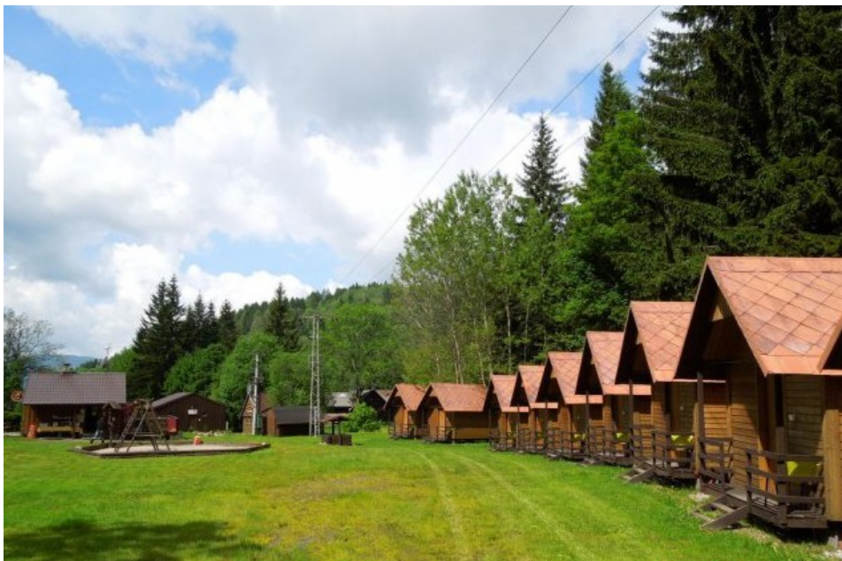
Výstavba stálého kempu s celkovou kapacitou 100 ubytovaných
