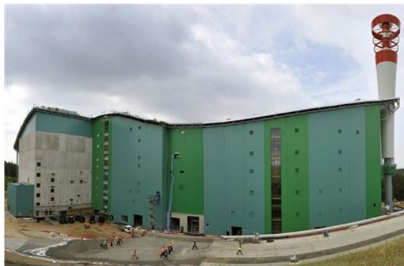
SPALOVNA KOMUNÁLNÍHO ODPADU V CHOTÍKOVĚ U PLZNĚ. | FOTO: ČTK
