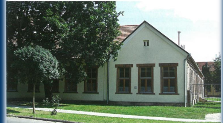
83. A Baranya Megyei Pedagógiai Szakszolgálat épülete Sásdon (2016)
