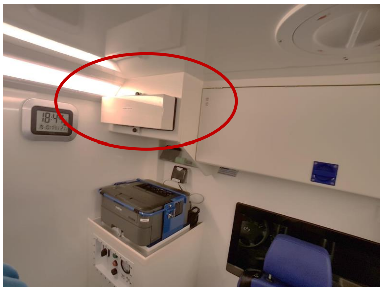
Obrázek 18 Speciální kryty na výdechy klimatizace
