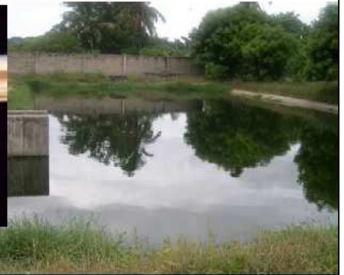
Nádrž s odpadní vodou, Tanzánie
