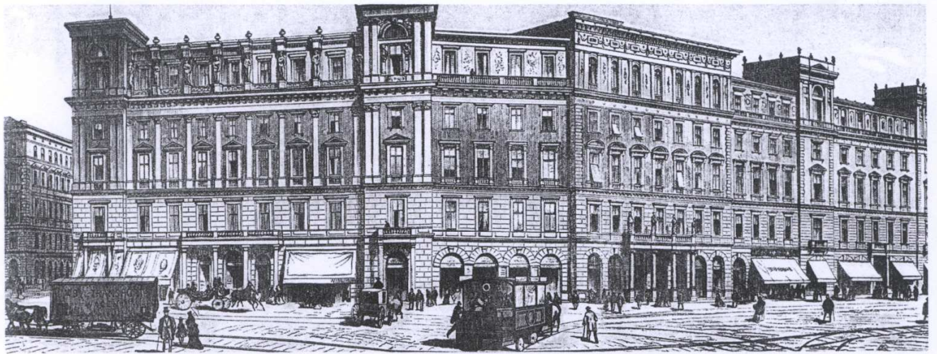
Dreihäusergruppe an der Ringstraße in Wien. Das mittlere Haus wurde nach Plänen von Ritter von Förster erbaut (nach einem Stich von L. E. Petrovits)
