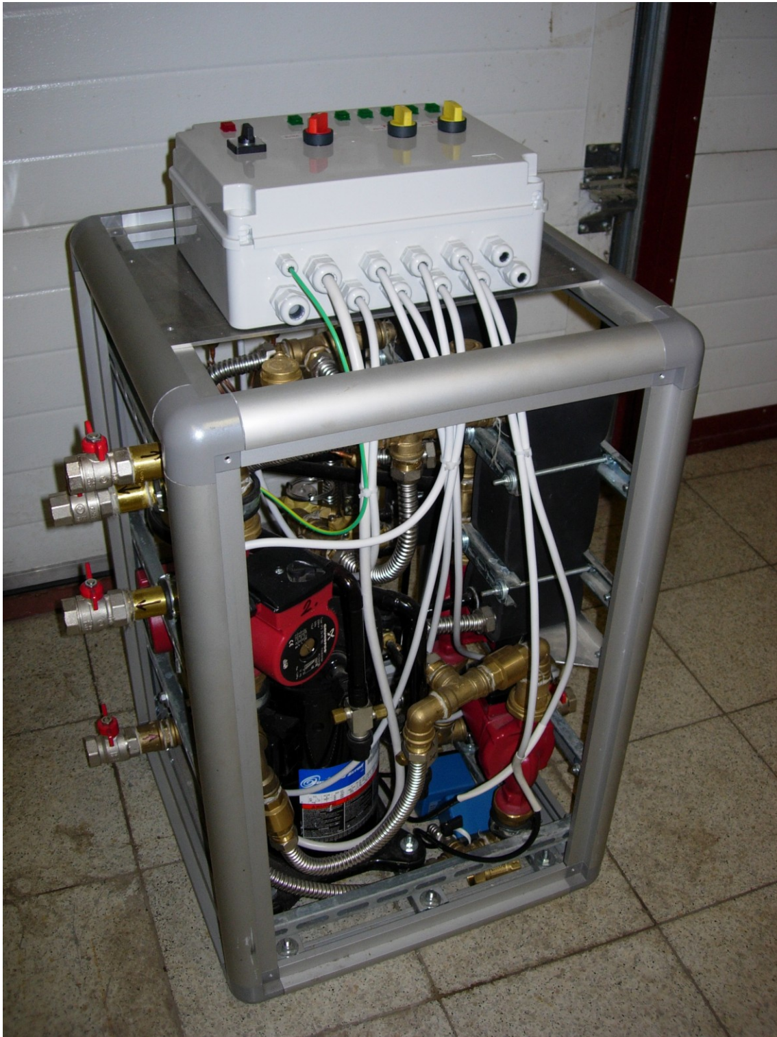
Obr. 5. Kompaktní jednotka s tepelným čerpadlem pro vytápění, ohřev vody a beznákladovou klimatizaci pasivního domu.
