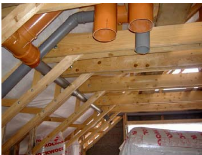
Obr. 7. Rozvody vzduchotechniky kanalizačními rourami v příhradových vaznících. Oranžové vývody v horní části obrázku jsou připraveny pro připojení podstropní rekuperační jednotky.
