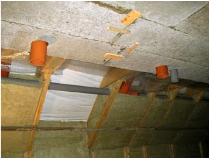
Obr. 9. Důkladná instalace kamenné vlny kolem rozvodů vzduchotechniky
