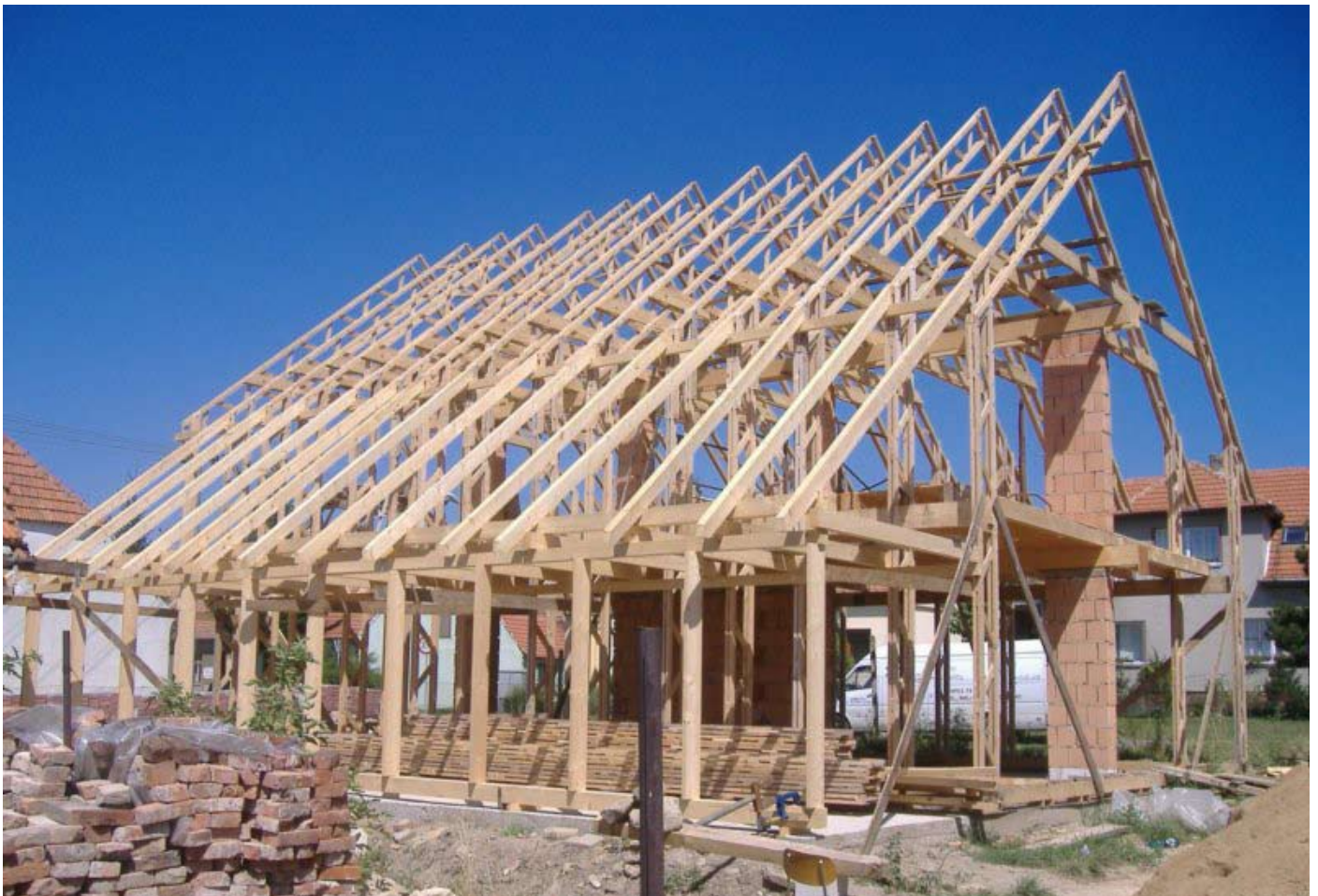
Obr. 2. Pohled na konstrukci domu z příhradových vazníků.
