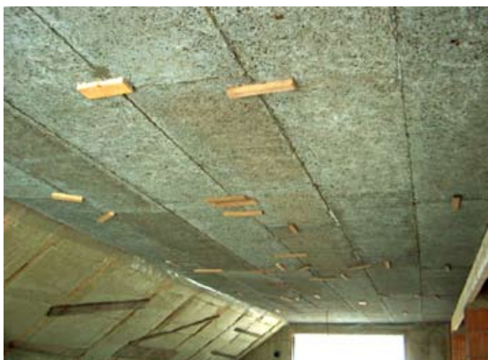
Obr. 5. Pohled na stropní podhled z Velox desek a na šikminu tepelně zaizolovanou deskami z kamenné vlny.
