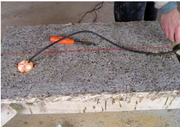
Obr. 11. Elektroinstalační krabici upevníme do předvrtaného otvoru ve Velox desce a zavedeme do ní kabely. Ty budou vedeny mezi parozábranou a Velox deskou. V místě styku s příhradovým vazníkem je nutno do Velox desky vydlabat pro kabel drážku.
