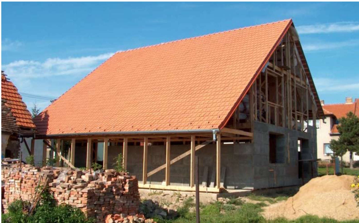
Obr. 3. Opláštění domu zvenjšku pomocí Velox desek.
