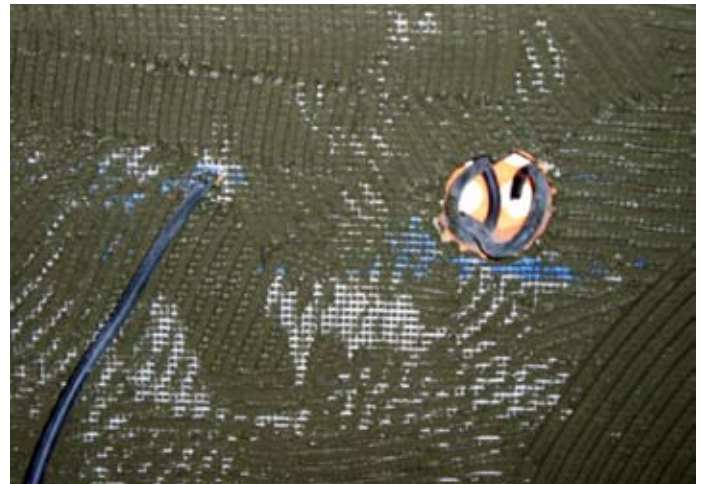
Obr. 11. Elektroinstalační krabici upevníme do předvrtaného otvoru ve Velox desce a zavedeme do ní kabely. Ty budou vedeny mezi parozábranou a Velox deskou. V místě styku s příhradovým vazníkem je nutno do Velox desky vydlabat pro kabel drážku.
