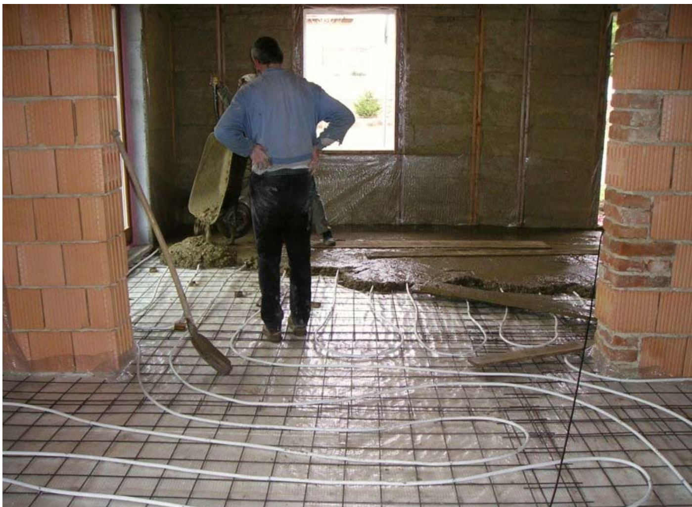
Obr. 15. Betonáž podlahové desky s podlahovým topením v přízemí. Vzdálenost hadic je asi půl metru a jejich instalace trvala asi půl dne.
