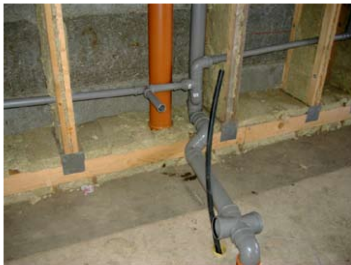
Obr. 7. Rozvody vzduchotechniky kanalizačními rourami v příhradových vaznících. Oranžové vývody v horní části obrázku jsou připraveny pro připojení podstropní rekuperační jednotky.
