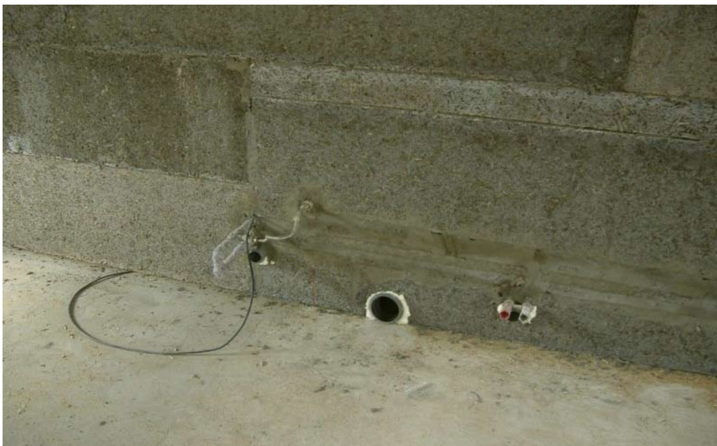
Obr. 14. Výška Velox desky je pro vedení vodovodních instalací plně postačující a trubky lze zapravit stavebním lepidlem nebo PUR pěnou.
