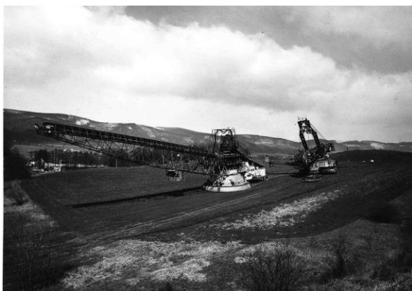
Transport kolesového rypadla K 300 a zakladače ZP 1500 po ukončení těžby na dole A. Zápotocký v roce 1978 na nově otevřený lom Chabařovice - délka transportní trasy 9,5 km
