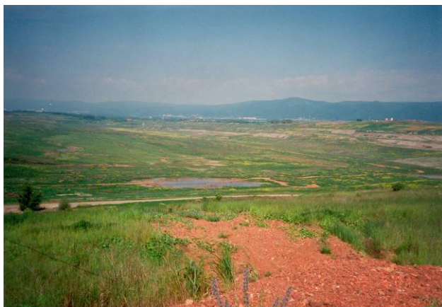
Zbytková jáma lomu Chabařovice po zasypání dna a utěsnění uhelné sloje zeminou v roce 2000 a vyklizení těžební technologie
