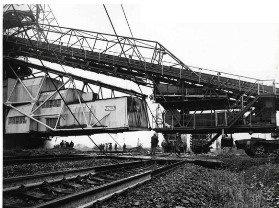
Transport velkostroje přes bývalou železniční trať Ústí nad Labem - Teplice
