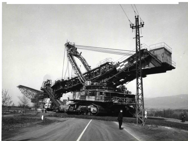
Transport velkostrojů přes komunikaci Ústí nad Labem - Chabařovice
