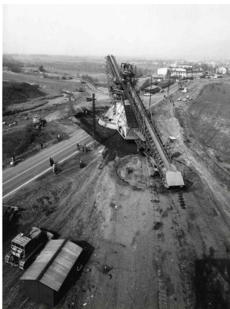
Transport velkostroje přes bývalou železniční trať Ústí nad Labem - Teplice
