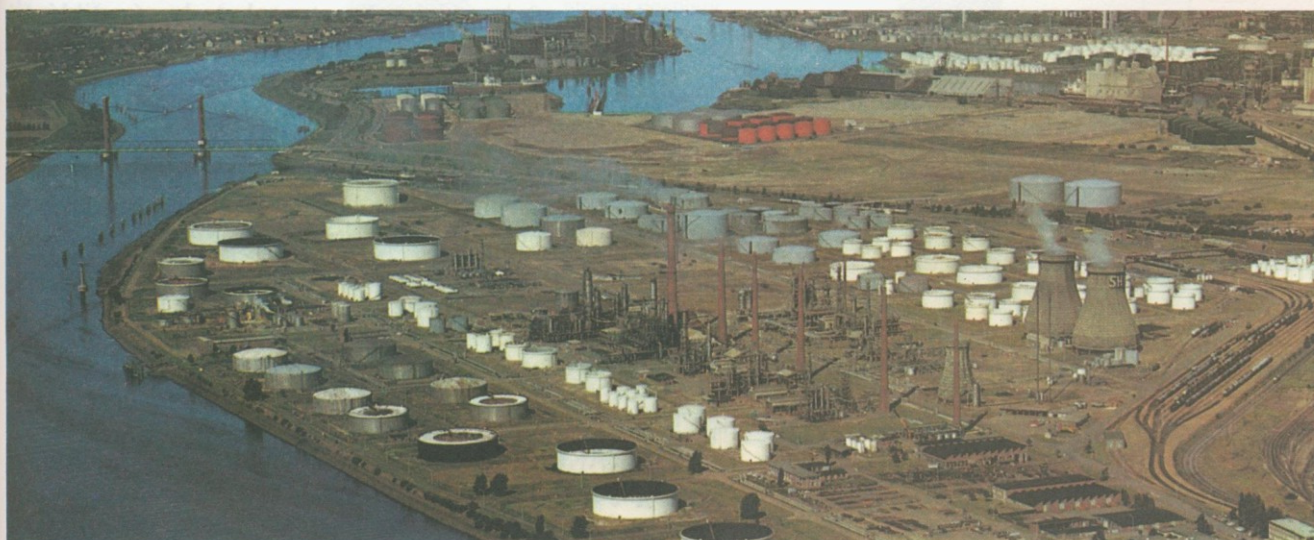
Obr. 111.3 Letecký snímek ropné rafinérie. Ropa se dopravuje vodní cestou, ropné výrobky se transportují po železnici a silnici
