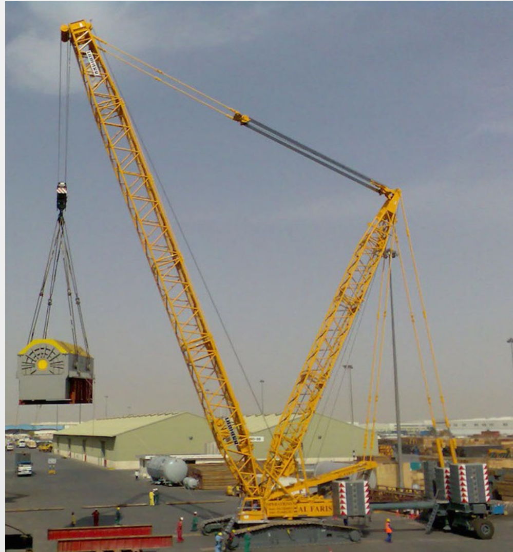
Zvedací zařízení na stavbách
