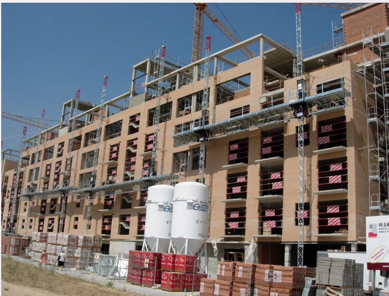
Zvedací zařízení na stavbách
