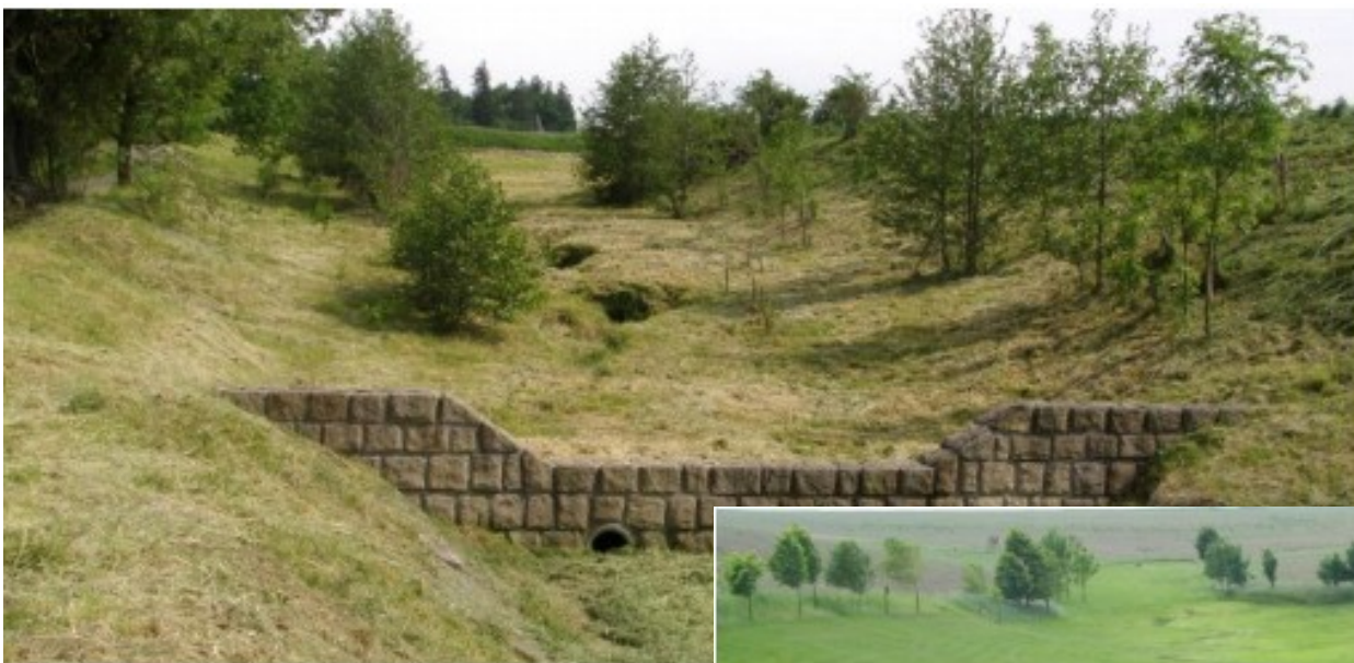
Protipovodňová přehrážka v k.ú. Lichnov
