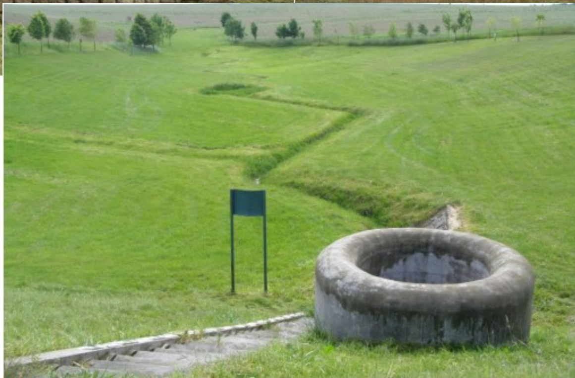
Suchá retenční nádrž v k.ú. Pustá Polom
