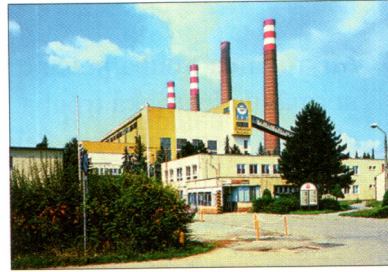
tepelná elektrárna Hodonín
