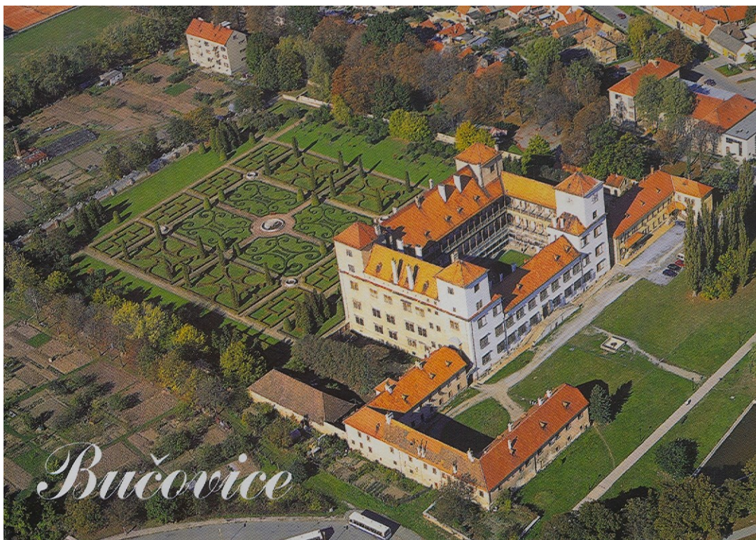
Renesanční zámek Bučovice, s manýristickými interiéry, má jednu z nejstarších dochovaných zahrad, tzv. italského stylu
