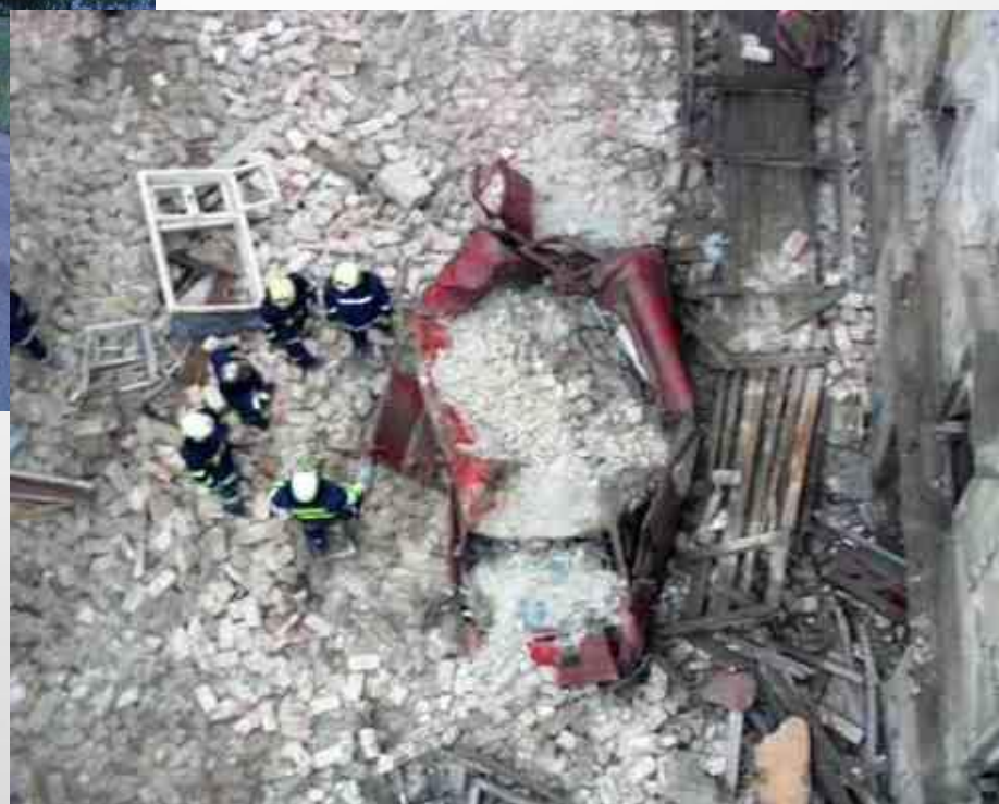
Obr. 10 Zřícení domu Brno 2002
