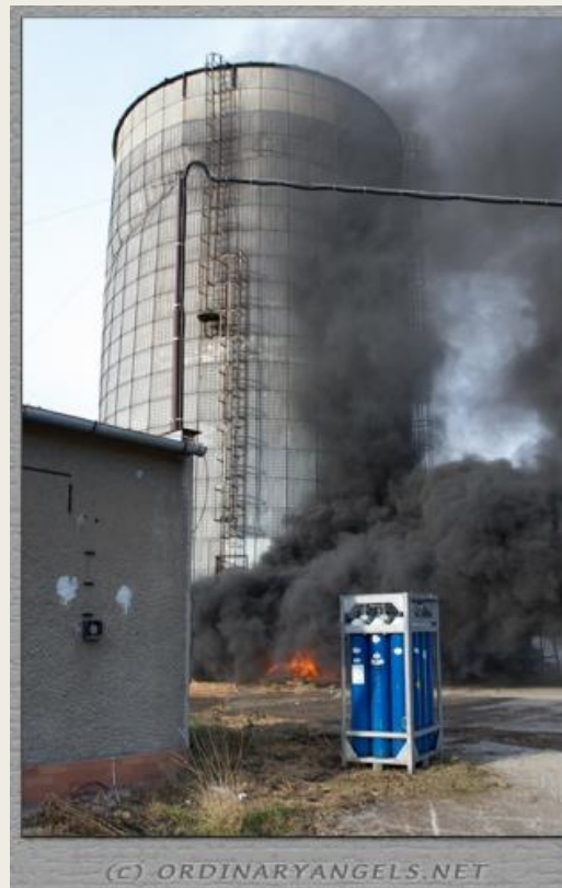
Obr. 2 Požár – nebezpečné látky
