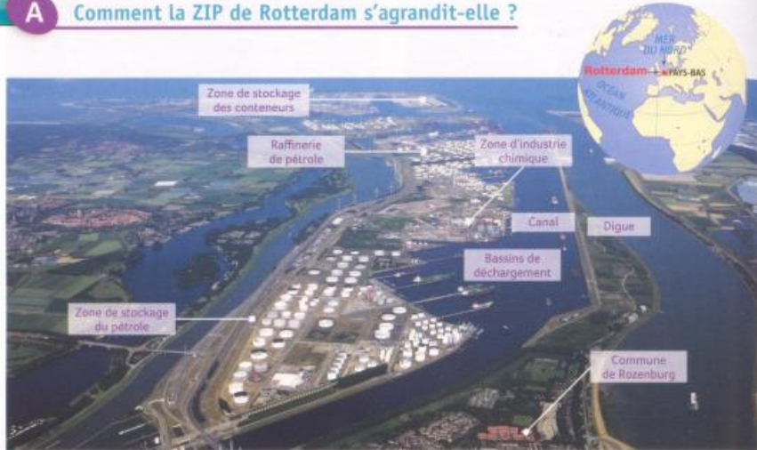
1 La ZIP de Rotterdam dans le secteur d'Europoort (2008) D'immenses terre-pleins ont été construits pour accueillir les aménagements du port.
