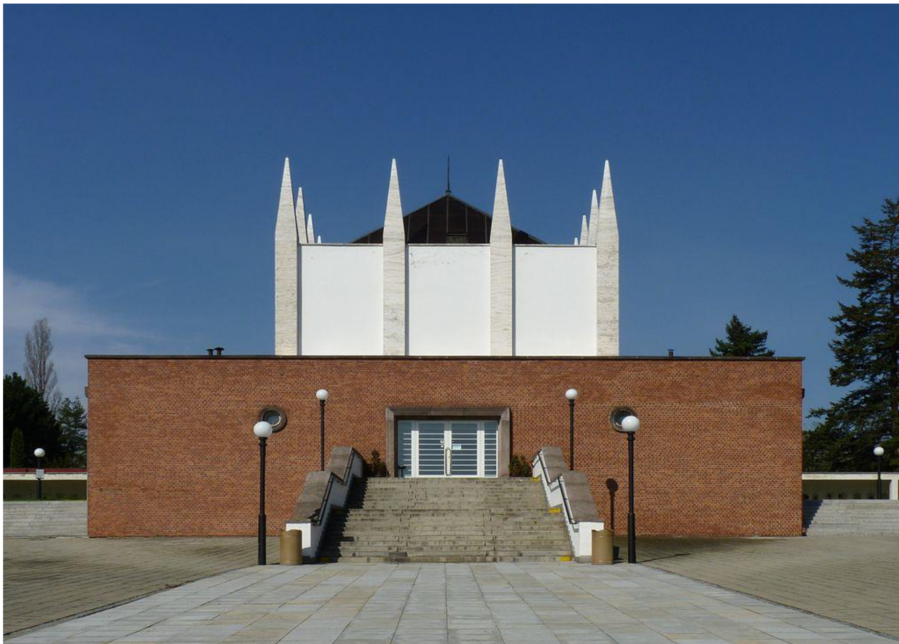
Arnošt Wiesner/ krematorium (Ústřední hřbitov v Brně) / 1925 - 30
