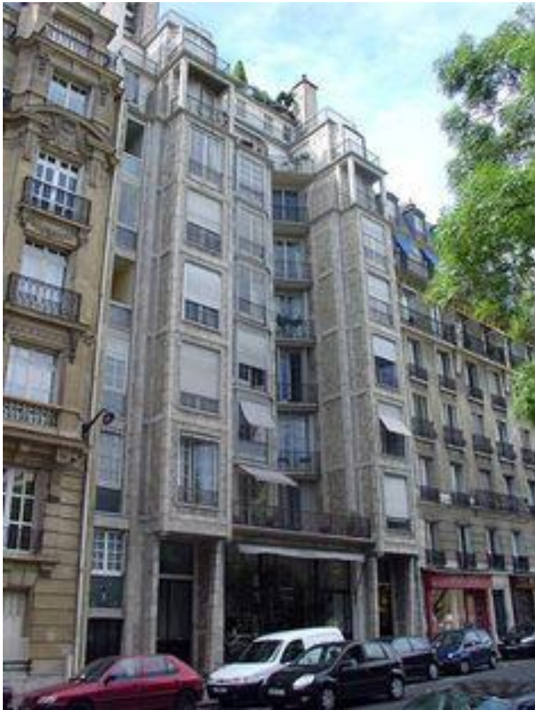
Auguste Perrault, dům ve Franklinově ulici, Paříž, 1902
