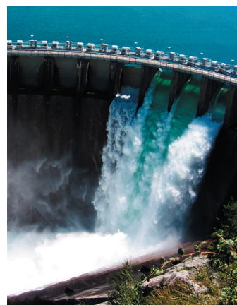
Obrázek 5-12. Přehradní hráz. Potenciální energie vody se mění na kinetickou.
