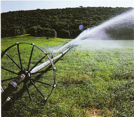
53/1 Zemědělské zavlažovací zařízení
