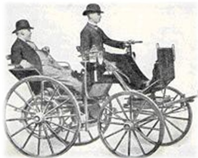
Daimlerův vůz – vozidlo na kolech poháněné plynovým nebo petrolejovým motorem umístěným pod sedadlem a mezi zadními nápravami.
