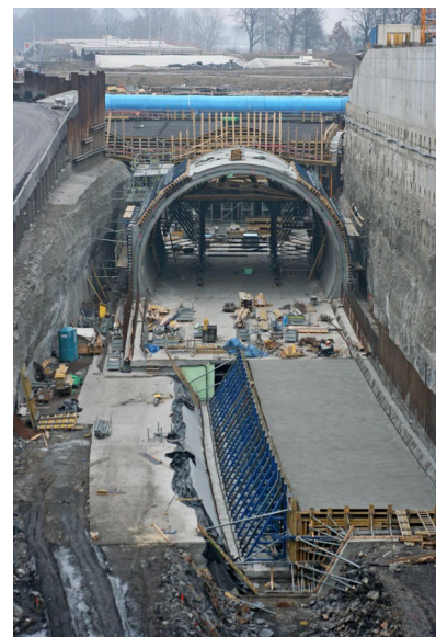
Stavba tunelu v pražské Tróji
