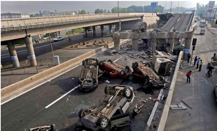
Zřícená mostní konstrukce při zemětřesení v Chile, zdroj: www.flicker.com
