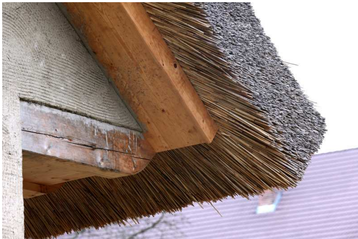
Obr. 6: Rodinný dům p. Čejna z Kruplova – detail střechy z rákosu
