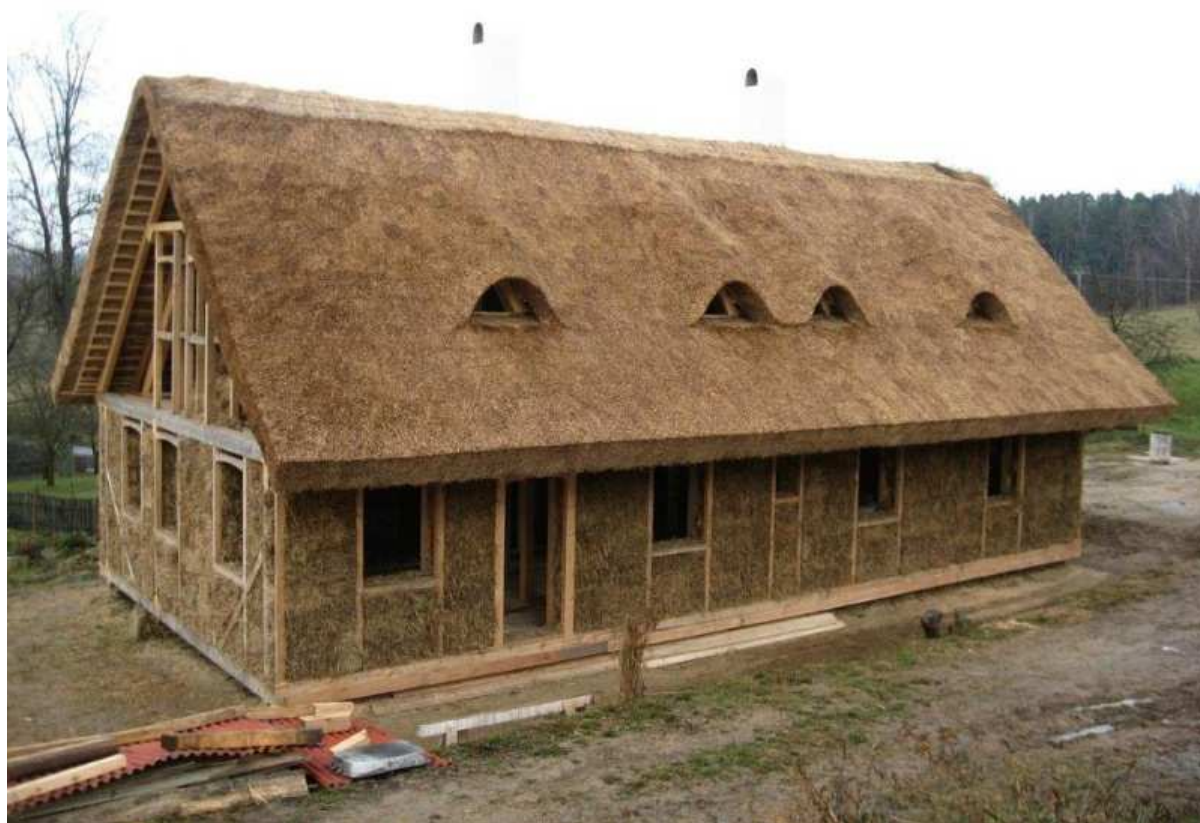
Obr. 5: Rodinný dům p. Čejna z Kruplova – slaměné balíky mezi dřevěnými trámkami
