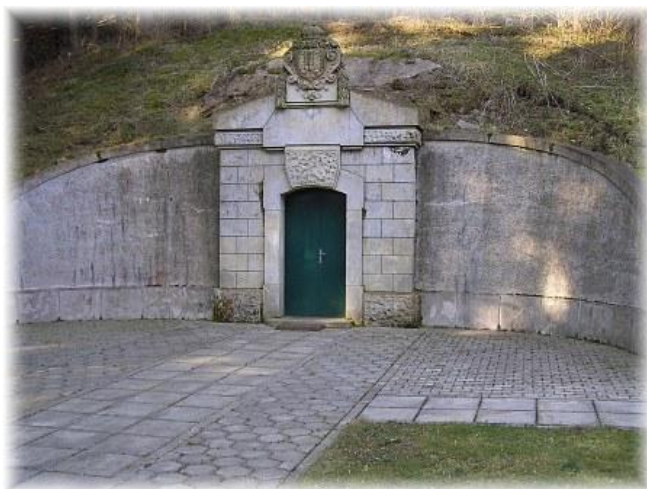
I. březovský vodovod – vstupní portál
