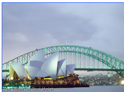
Sydney s budovou Opery a Přístavním mostem.
