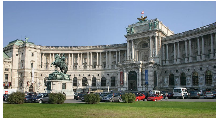
Die Neue Burg , der Südostflügel der Wiener Hofburg
