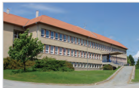
Budova nové školy
