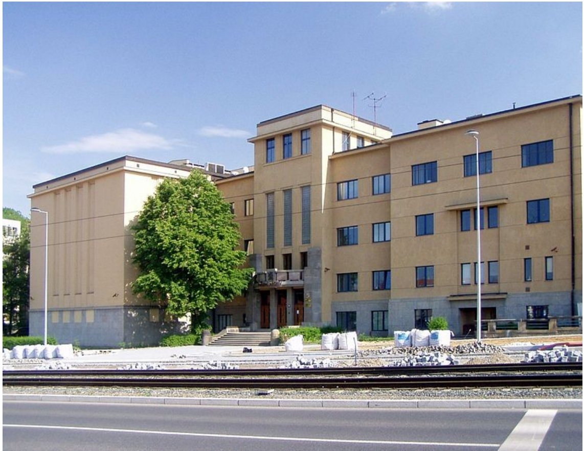
Budova Národního archivu v Praze na ul. Milady Horákové (starší fondy)
