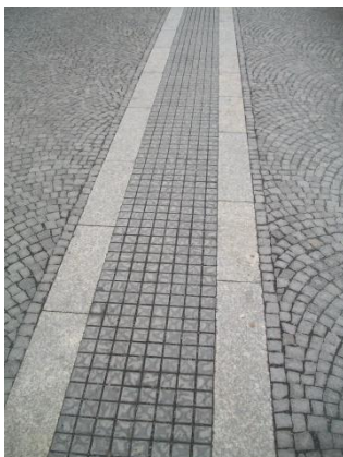
Obrázek č. 60 – Vodící pruhy v dlažbě
