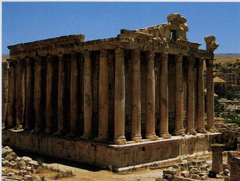
Bakchův chrám v Baalbeku v Libanonu (asi 150–200 po Kr.) stojí na typické římské vysoké plošině, ale má neobvyklý řecký peristyl z volně stojících sloupů.
