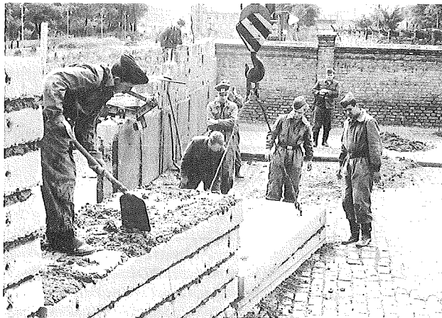
◀ 13. August 1961: Der Mauerbau in Berlin zementiert die jahrzehntelange Teilung Deutschlands. Ein von Grenzsoldaten bewachter Bautrupps bei der Arbeit an der Mauer
