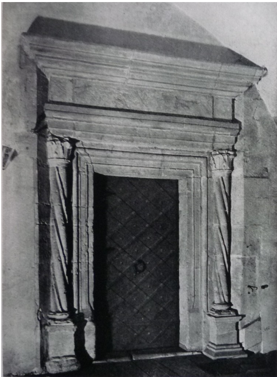
5. Praha, Hrad, Ludvíkovo křídlo, portál; před 1509
