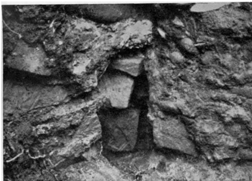
Obr. 14. Základy gotickej sakristie a apsidy a nárožia stavby pravdepodobne románskej v Lipt. Sv. Mikuláši.
