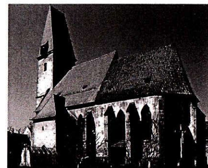
1 Rychnov nad Malší, kostel sv. Ondřeje, fotografie z roku 2005, na které je vidět skutečná návaznost zdva kněziště a lodí v jedné přímkce bez zakreslovaného ústupku.
