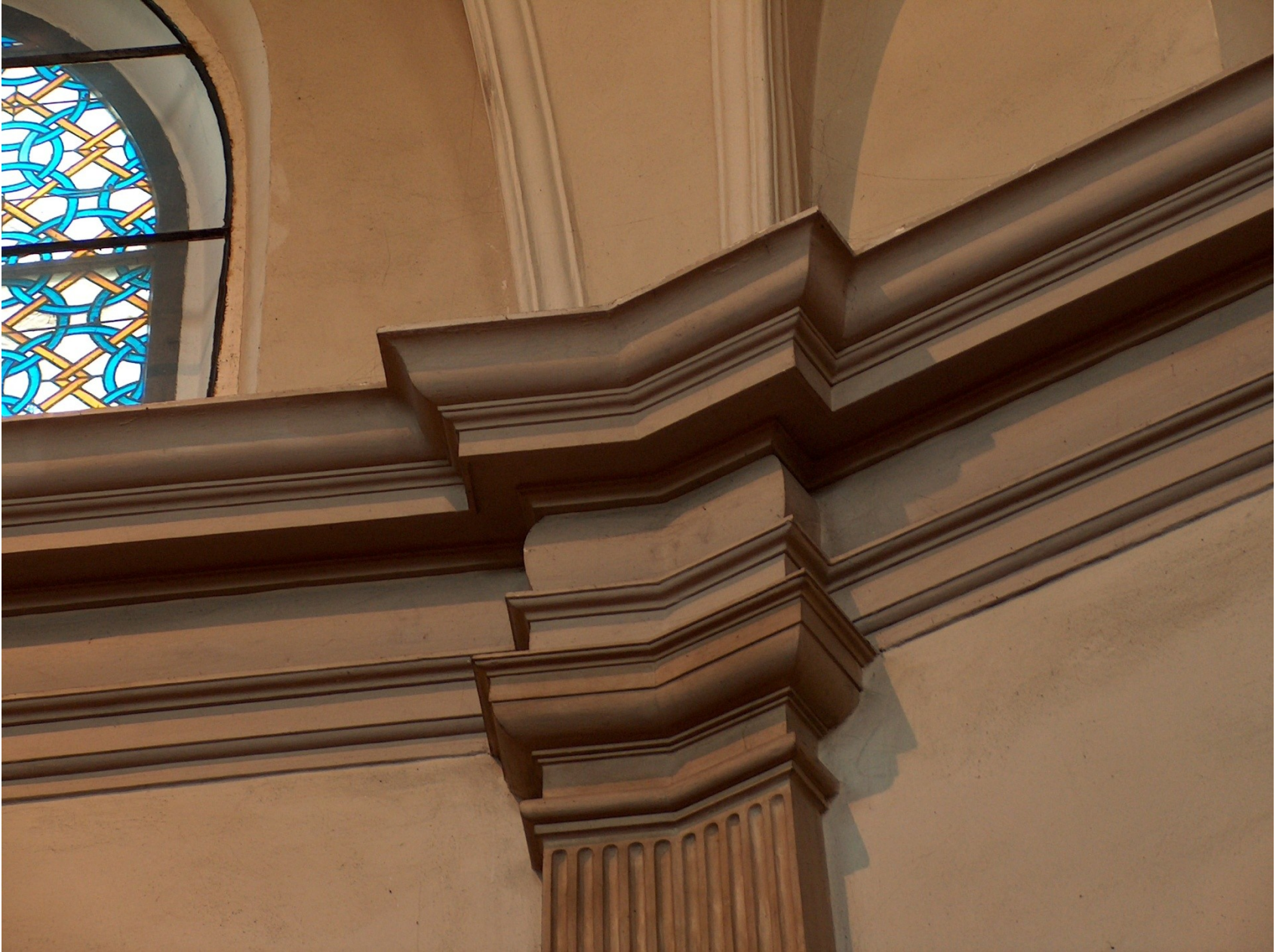
Kaple sv. Anny, 1617, detail úseku římsy se zalamovaným kladím
