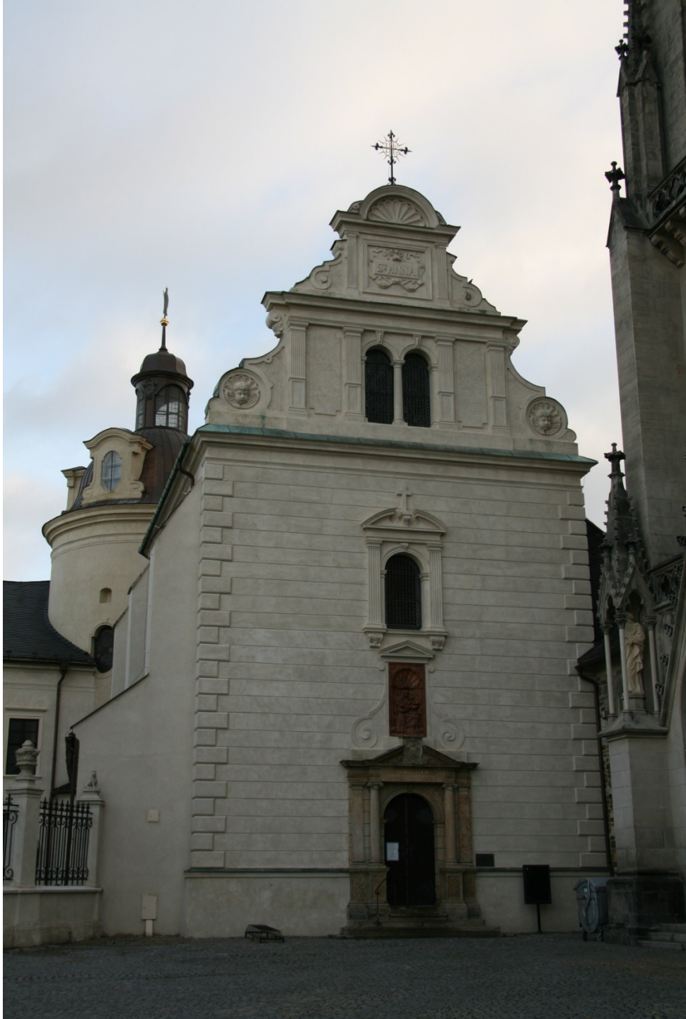
Kaple sv. Anny, průčelí, 1617 (1885)
