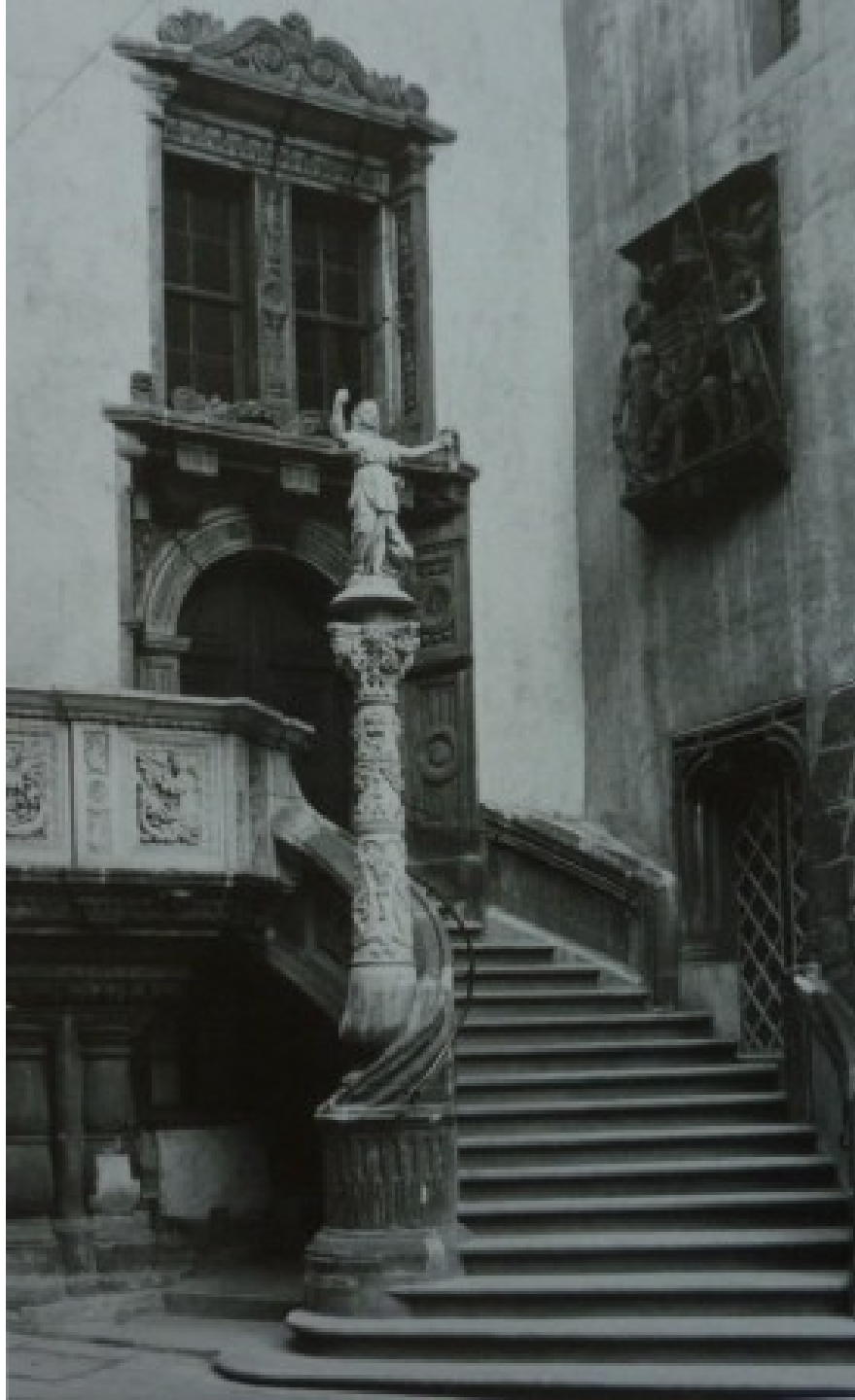
Schodiště a řečnický pult ve Žhořelci, radnice - 1537
