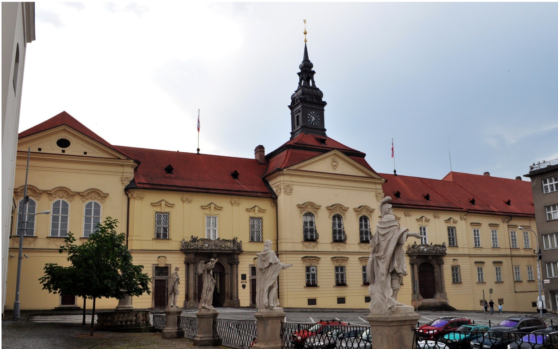
Nová radnice (původně Zemský dům) hlavní průčelí, 1726-29
