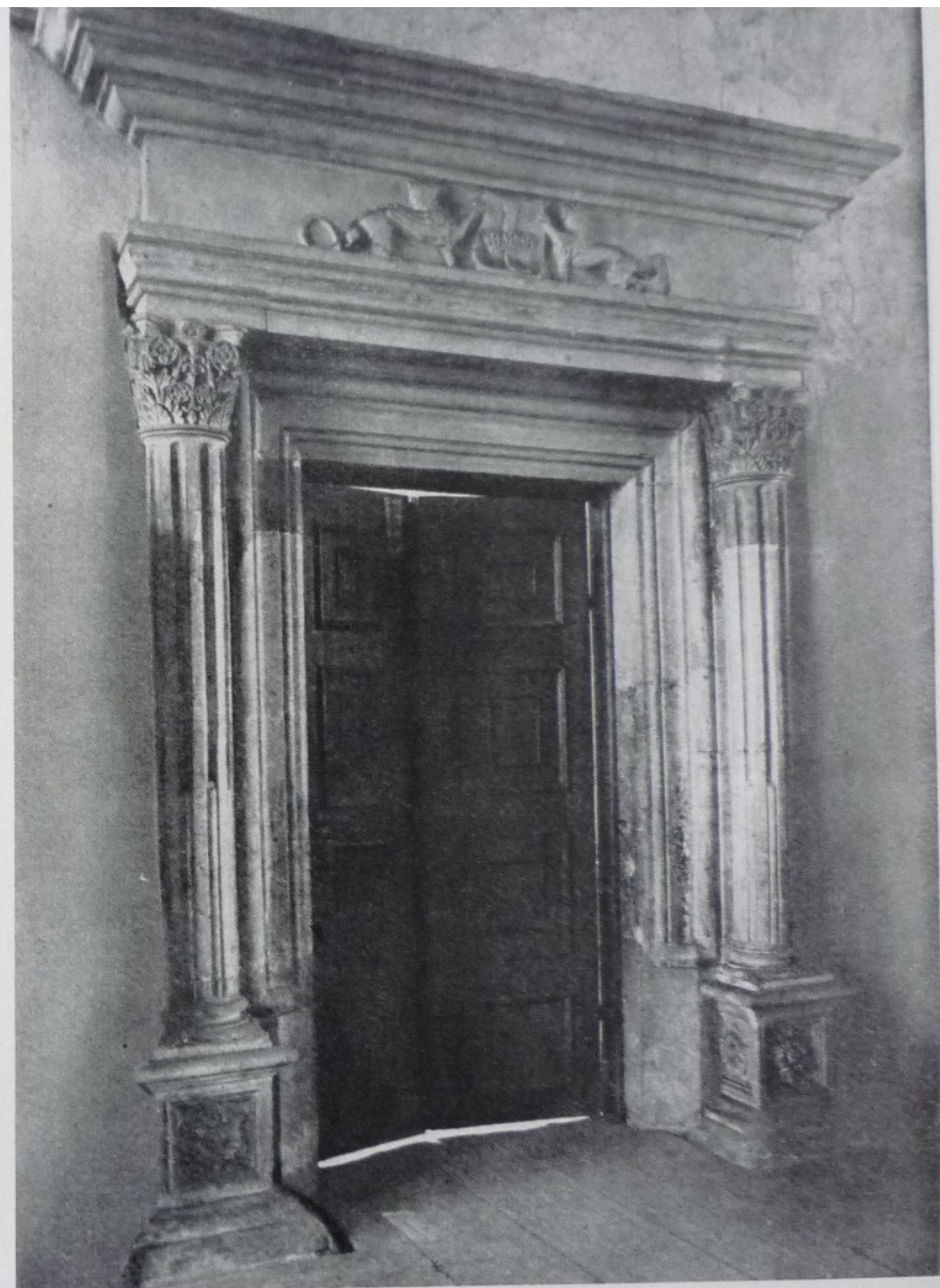
6. Praha, Hrad, Ludvíkovo křídlo, portál v prvním patře; před 1509
