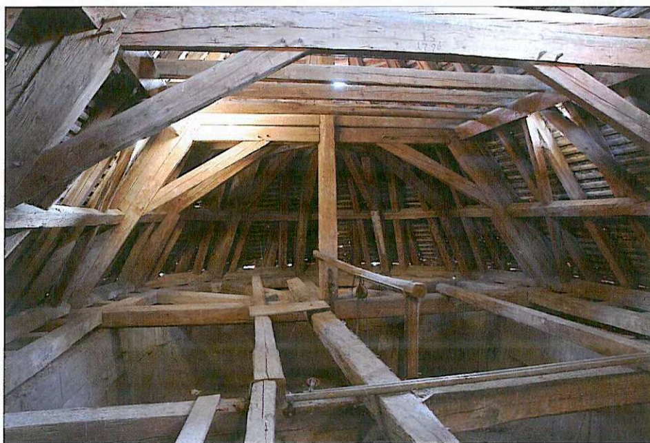
Obr. 6: Výšovice, kostel sv. Vavřince. Pohled do partie krovu nad kněžištěm.
