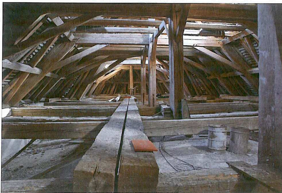
Obr. 4: Výšovice, kostel sv. Vavřince. Průhled podkrovím směrem k jihovýchodu (další foto a kresby O. Belšík).
