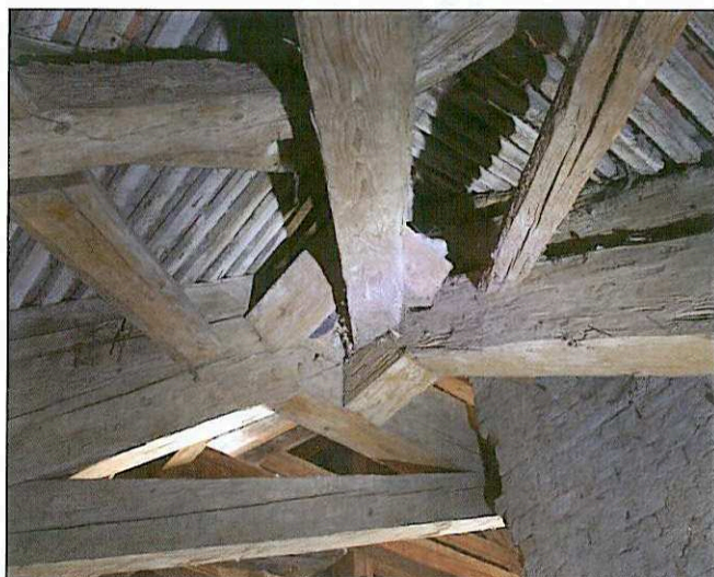
Obr. 19: Výšovice, kostel sv. Vavřince. Pohled do horní části styku vazeb při severním nároží (valbě) partie krovu nad lodí.
