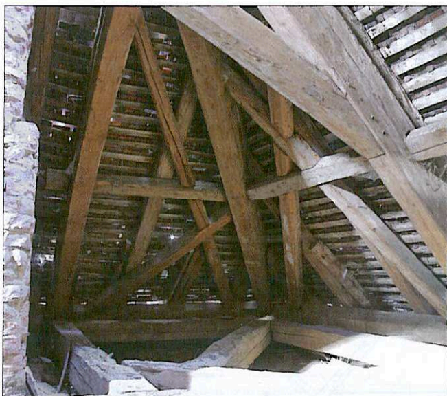
Obr. 18: Výšovice, kostel sv. Vavřince. Severní nároží (valba) v partii krovu nad lodí.
