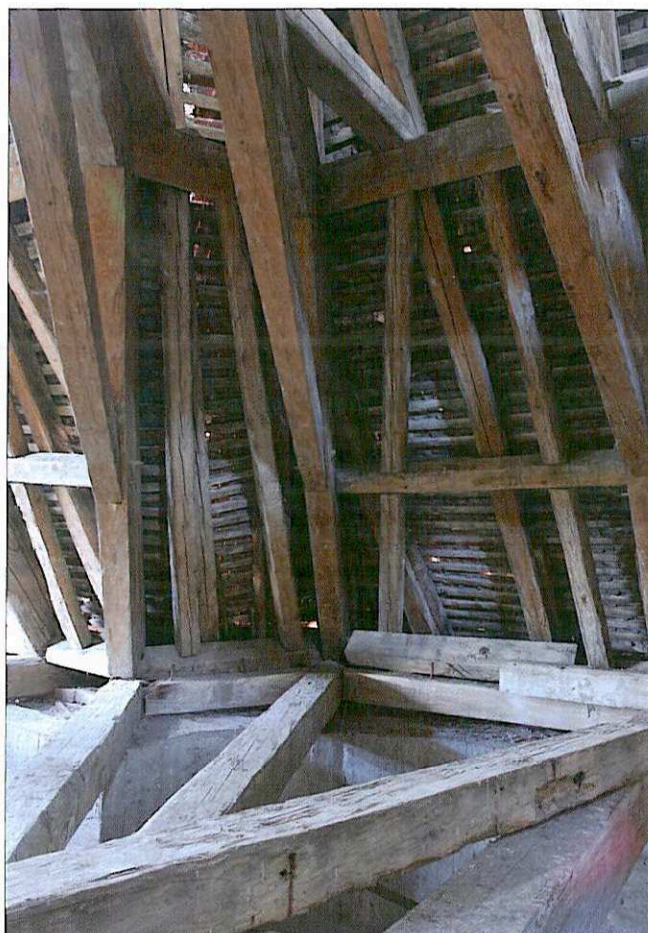
Obr. 20: Výšovice, kostel sv. Vavřince. Řešení přechodu konstrukce krovu mezi lodí a kněžištěm v úrovni sloupků ležaté stolice (JZ partie krovu)
