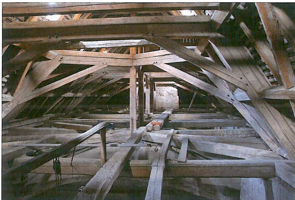
Obr. 5: Výšovice, kostel sv. Vavřince. Průhled podkrovím směrem k severozápadu.
