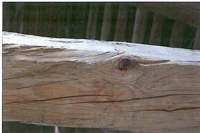
Obr. 23: Výšovice, kostel sv. Vavřince. Vyznačení osy vazby linkou vyrytou ostrým či špičatým předmětem a nápisem rudkou „mít!“ na spodní straně horního hambalku 31. vazby (1. plně příčné vazby) v partii krovu nad kněžištěm.
