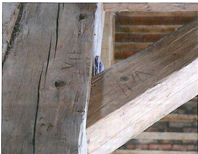
Obr. 16: Výšovice, kostel sv. Vavřince. Tesařské montážní značky provedené rudkou (arabská číslice) a dlátem nebo dlátovkou (římská číslice) na věšáku 4. plně příčné vazby a na zavětrovacím pásku podélného vázání v ose partie krovu nad lodí (pohled od JZ).
