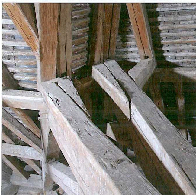
Obr. 21: Výšovice, kostel sv. Vavřince. Lípnutí velmi krátkých hambalků (krátkat) k boční straně delších hambalků vazeb tvořících přechod mezi lodí a kněžištěm (JZ partie krovu).
