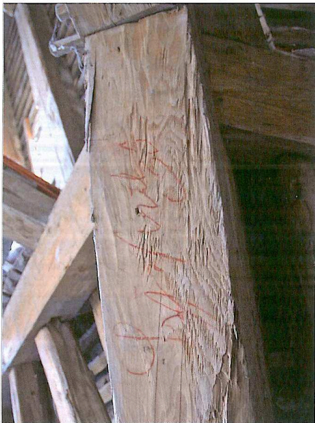
Obr. 24: Výšovice, kostel sv. Vavřince. Nápis „Brzesowitz 5“ (?) provedený rudkou na sloupku stolice 30. (úboční) plné vazby v JZ části krovu.
