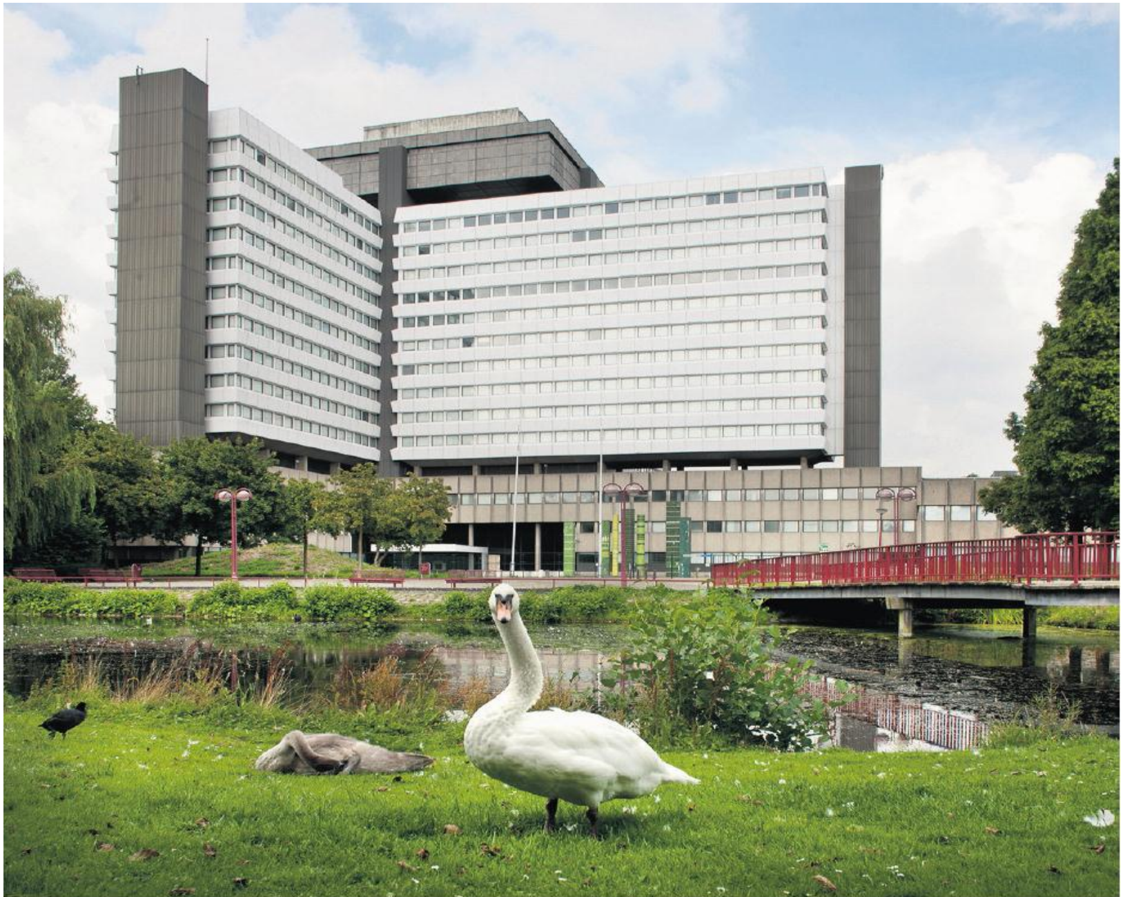
Het leegstaande CBS-gebouw in Voorburg. „Pure verspilling van ruimte.” Foto Merlin Daleman
