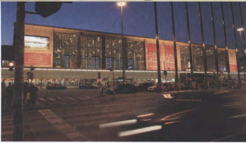
Westbahnhof, Wien. Architektur: Robert Hartinger, Sepp Wöhhart und Franz Xaver Schlarbaum, 1949-54 Západní nádraží, Vídeň. Architektura: Robert Hartinger, Sepp Wöhhart a Franz Xaver Schlarbaum, 1949-54
