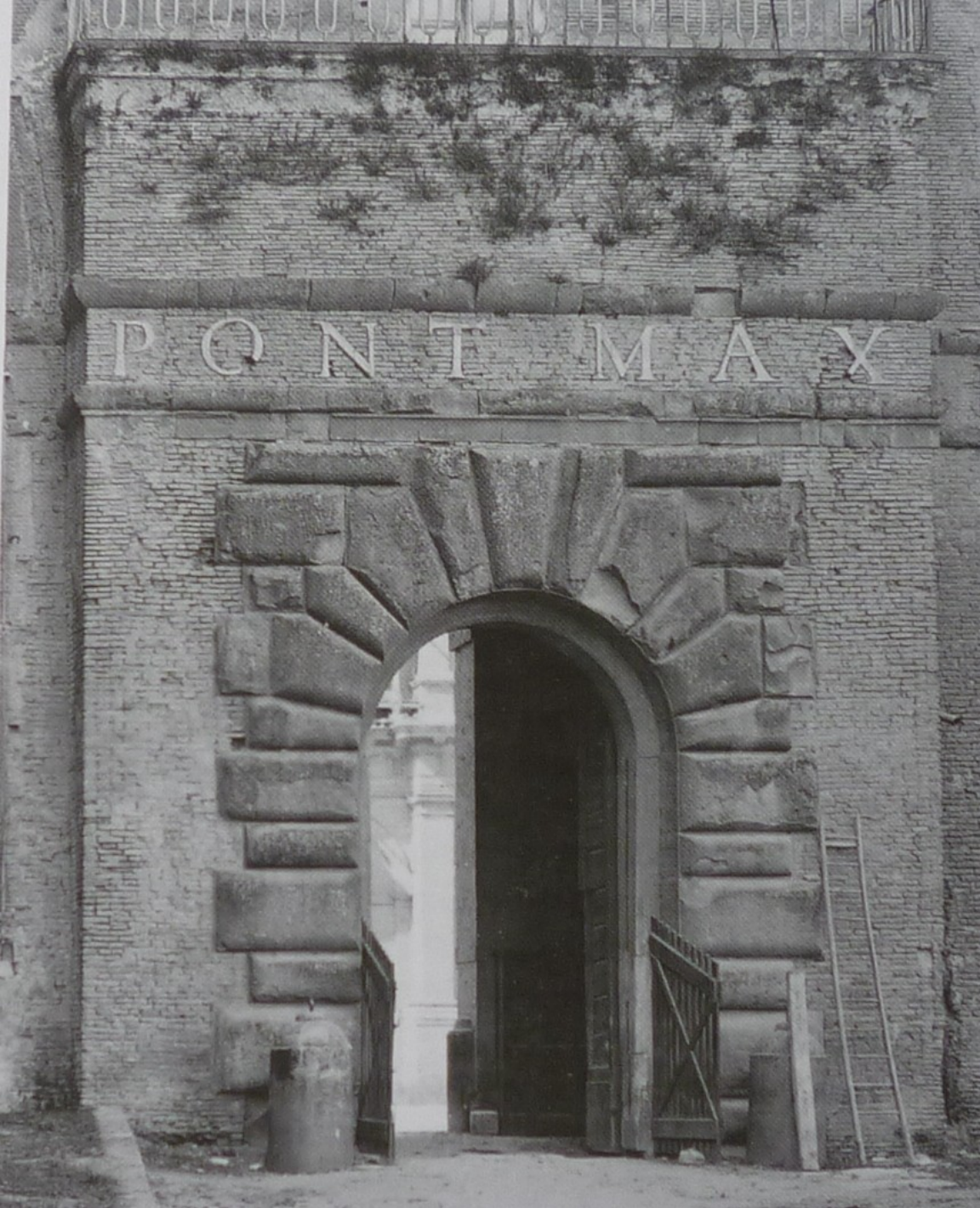
Východní portál Belvederského nádvoří
