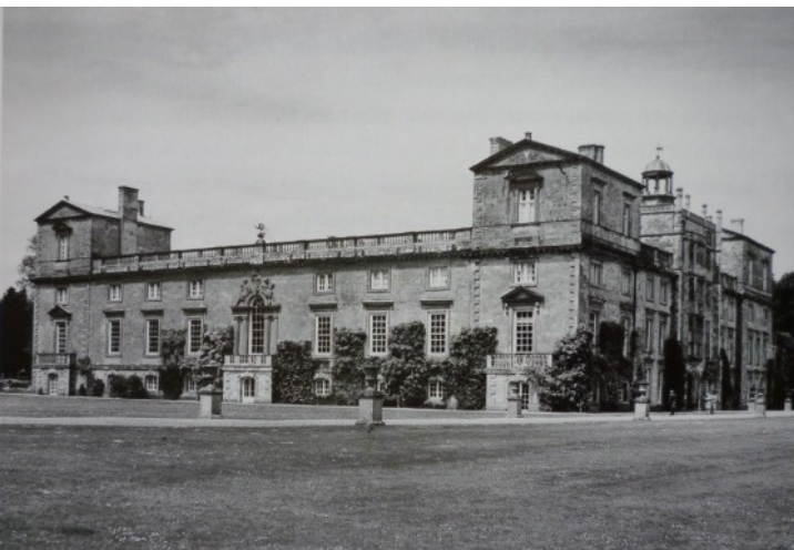
Inigo Jones – Isaac de Caus, Wilton House, Wiltshire, 1636-40, jižní fasáda
